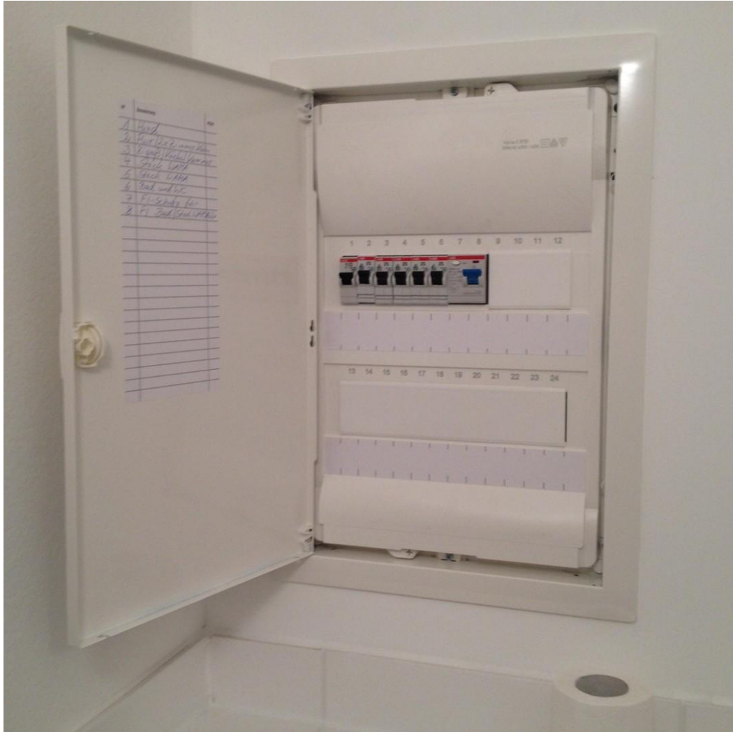
neuer Sicherungskasten
