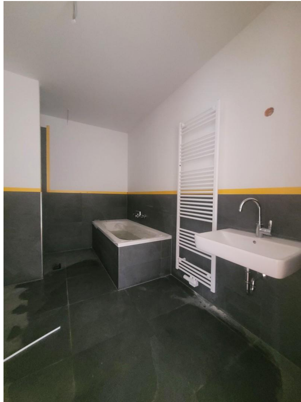
Bad 2 (noch im Bau)
