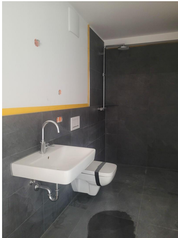
Bad 1 (noch im Bau)
