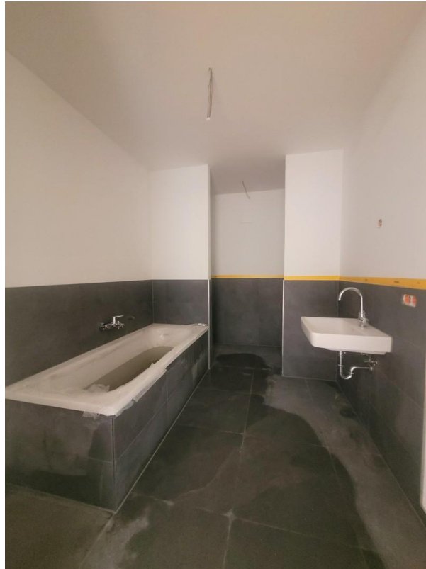
Bad 1 (noch im Bau)
