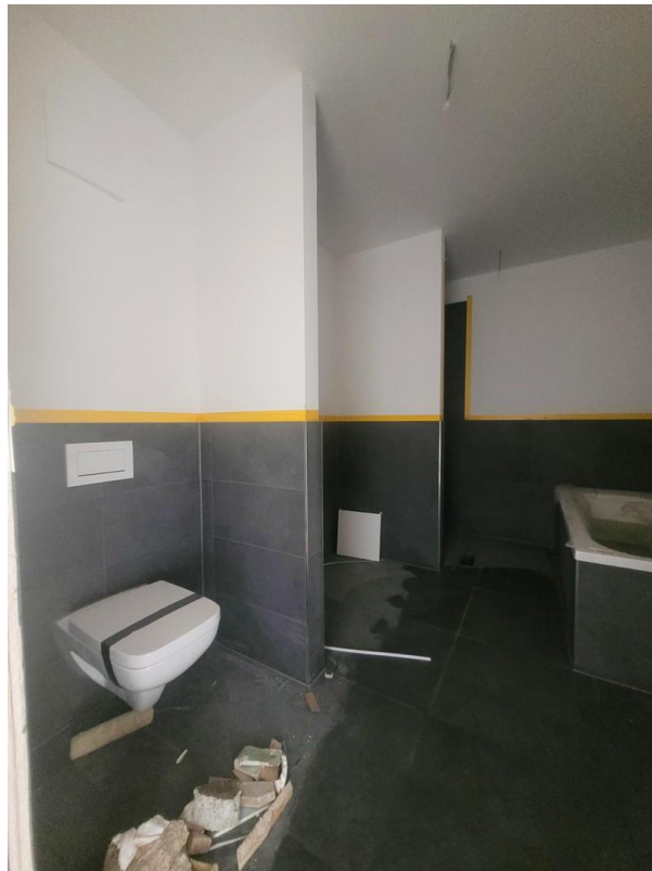
Bad 2 (noch im Bau)
