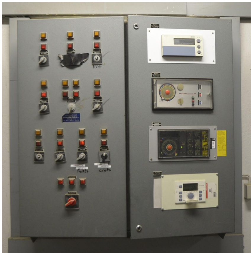
Schaltschrank Fernwärme
