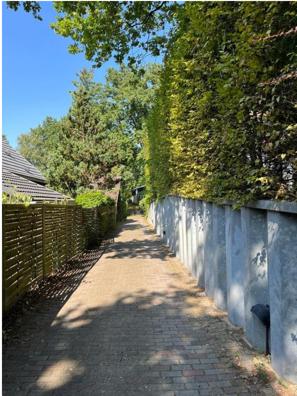
Zufahrt mit Spundwand
