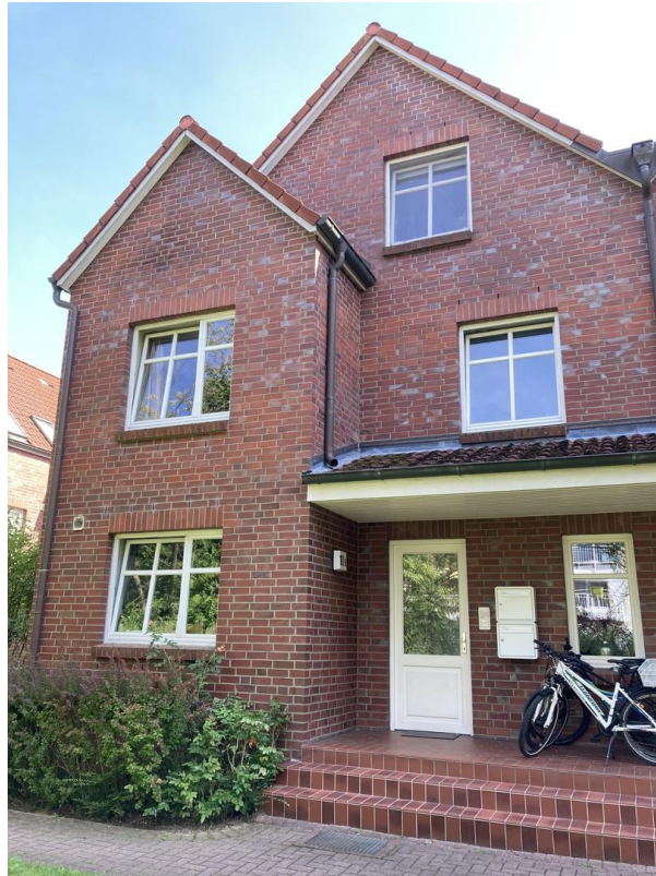
Rückansicht - Eingang Bild 1
