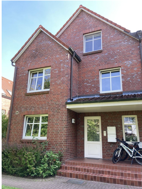
Rückansicht - Eingang Bild 1
