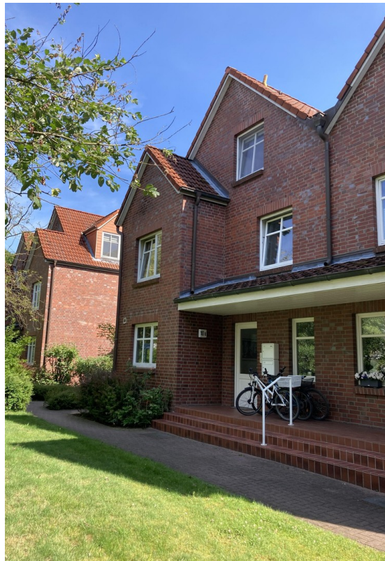
Rückansicht - Eingang Bild 2
