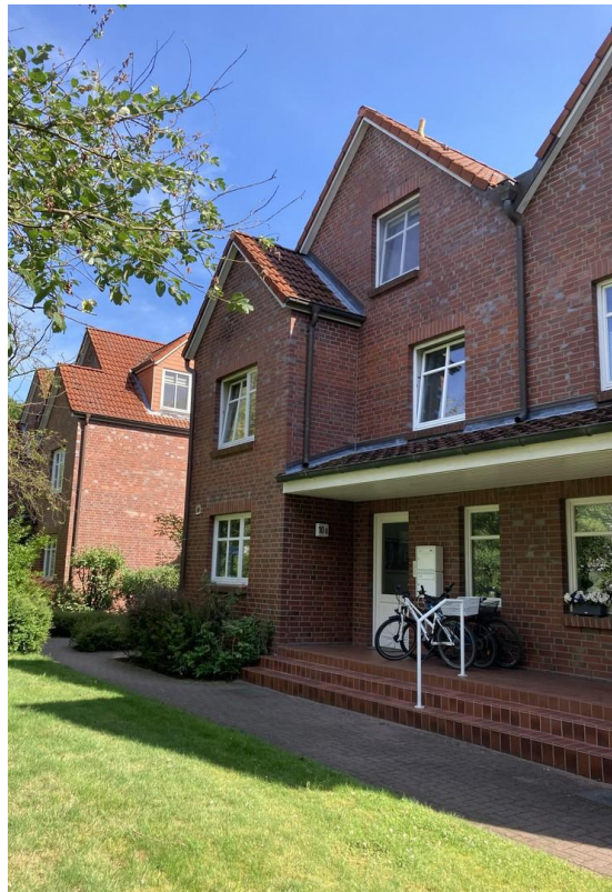
Rückansicht - Eingang Bild 2
