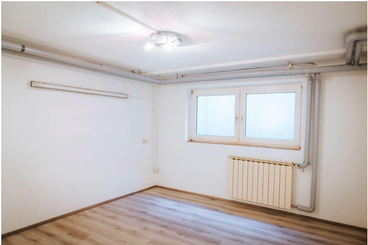
Einer der Kellerräume
