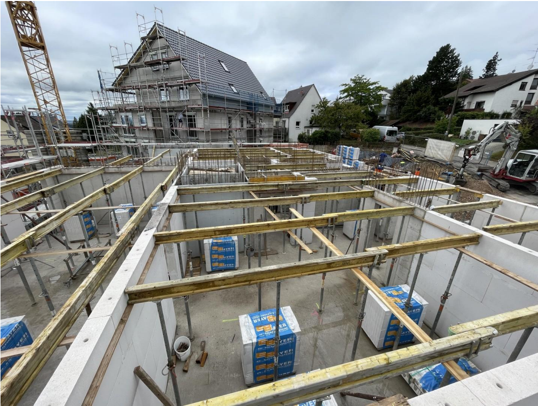
Blick auf Haus 42 + TG/Keller
