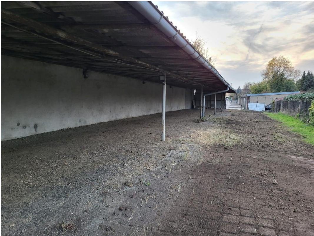
Überdachter PKW Stellplatz
