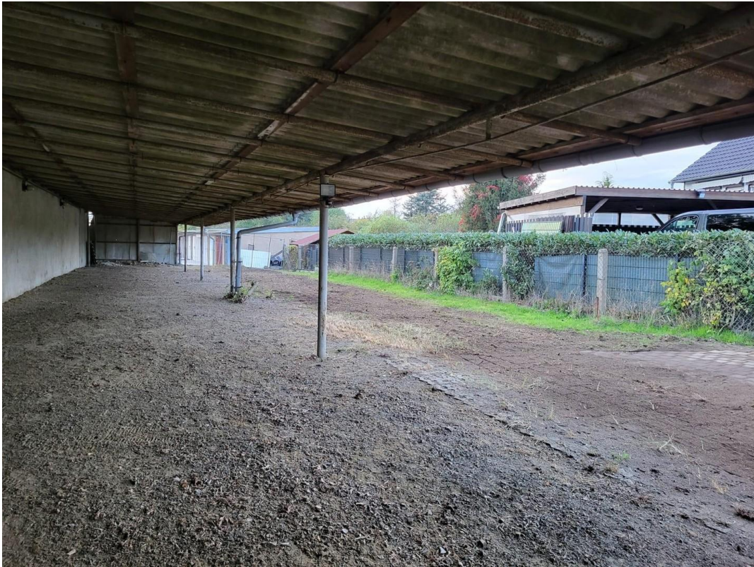
Überdachter PKW Stellplatz
