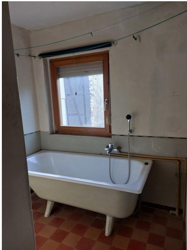
Anbau Bad Obergeschoss
