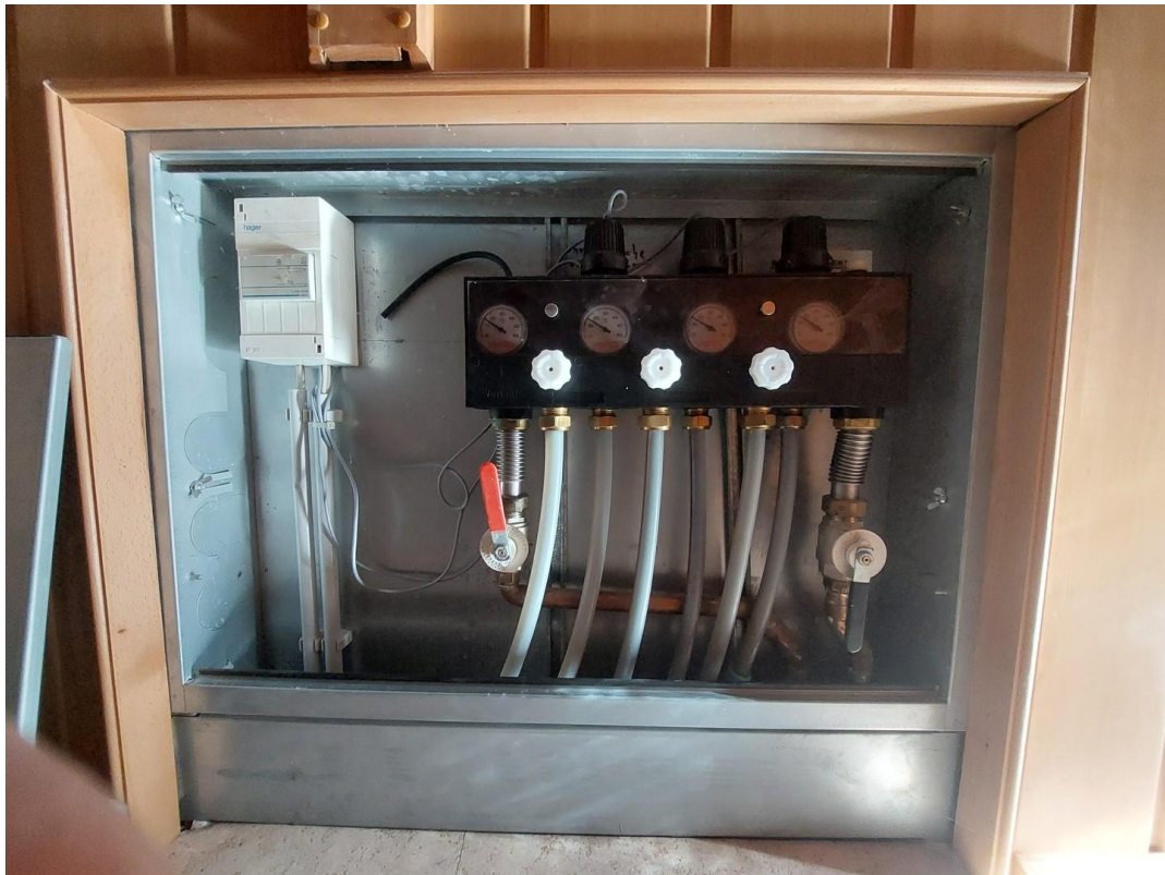
Regelung Fußbodenheizung
