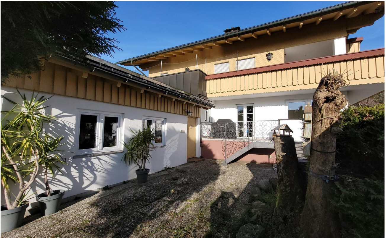
Blick auf Anbau und Westseite
