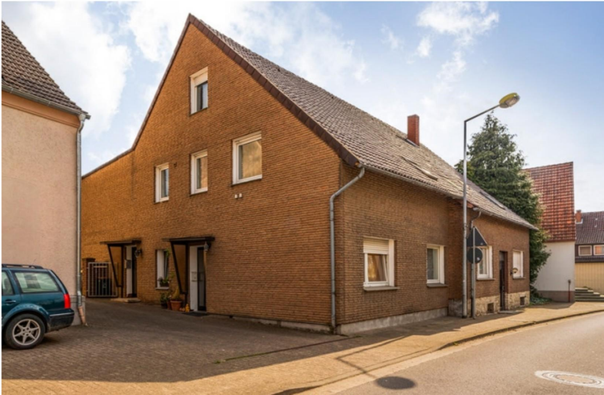
Haus von der Straße
