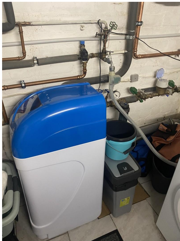
Entkalkungsanlage
