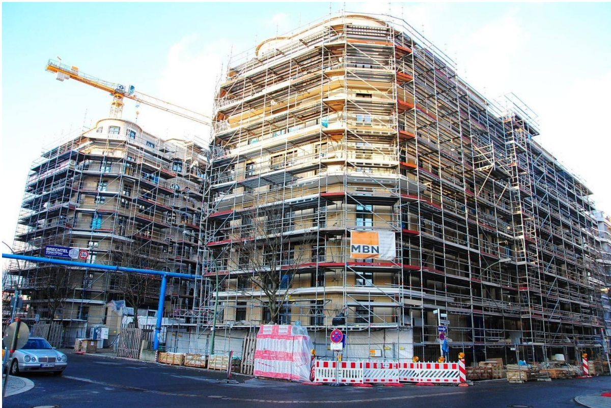
Gerüst Bauphase Fellini 2013
