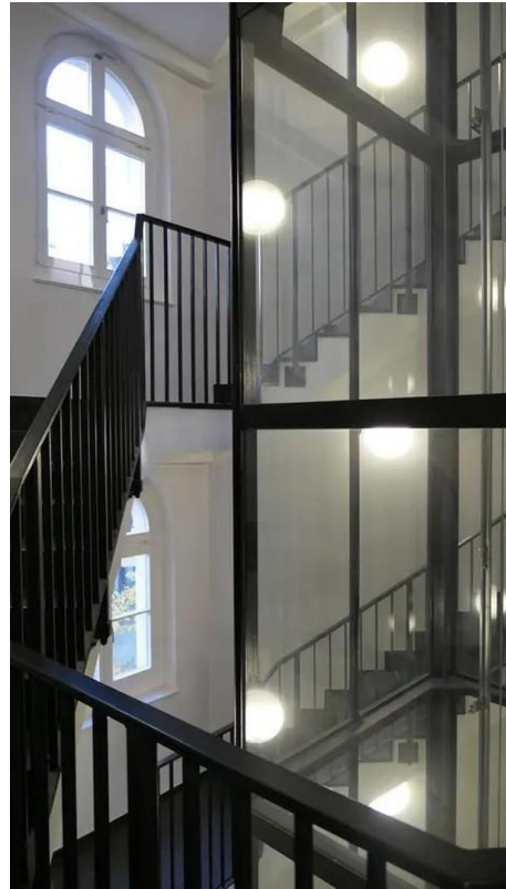
Treppenhaus mit Aufzug
