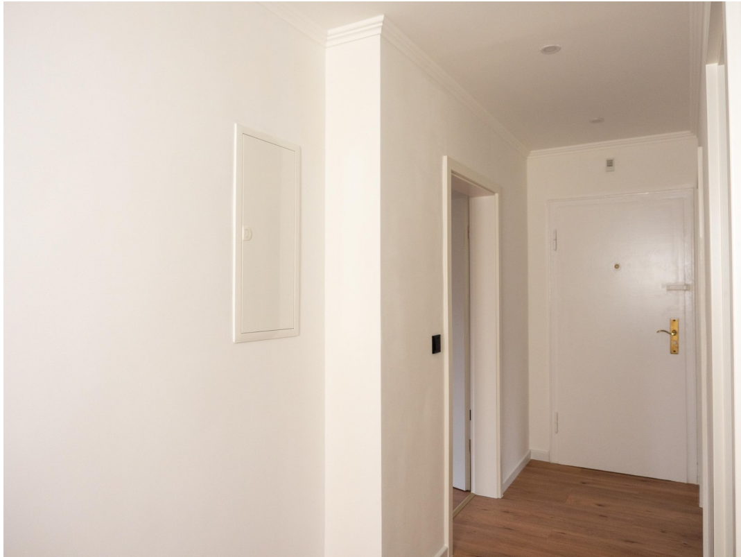
Diele mit neuem Schaltkasten
