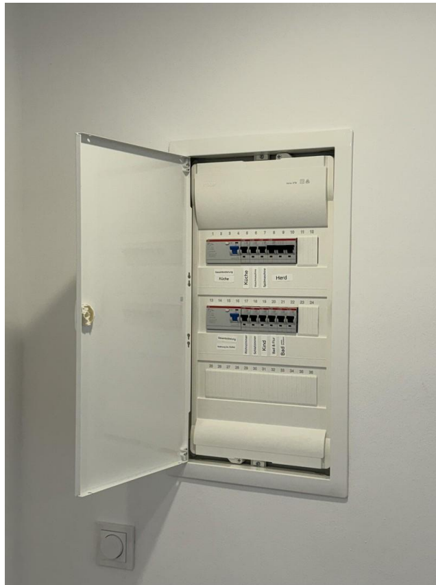
Neuer Sicherungskasten
