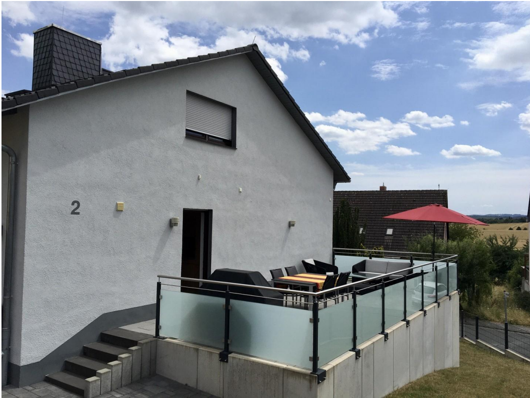
Küchentür zur West-Terrasse
