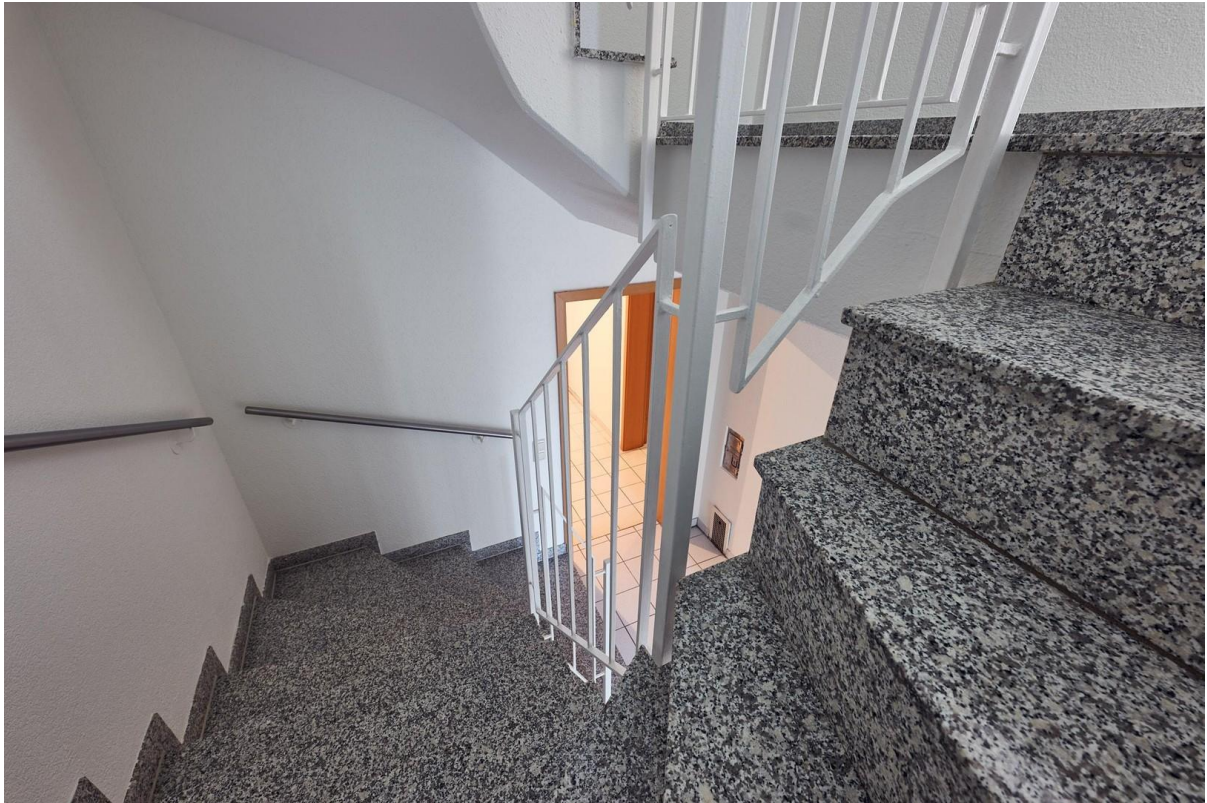
Treppenhaus vom EG in das OG
