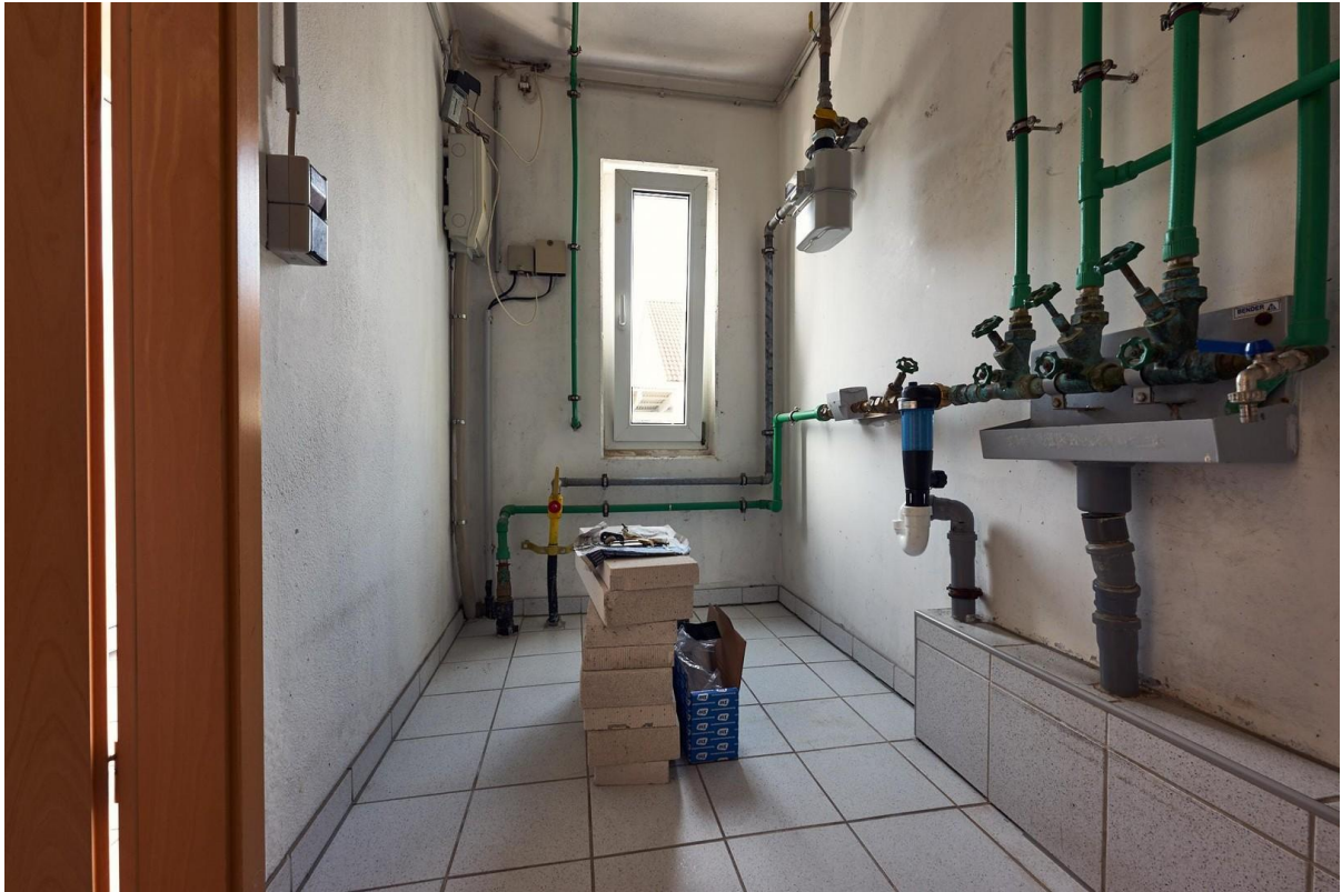
Versorgungsraum im EG
