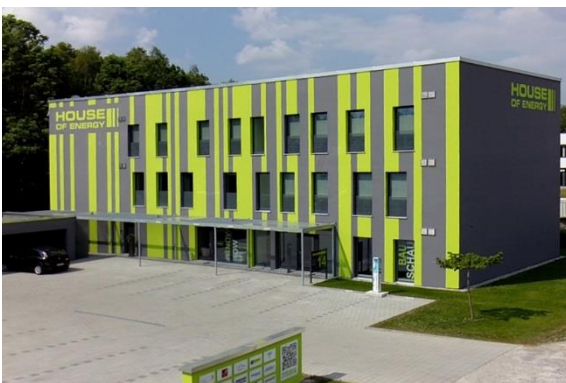
Das neue „Passivhaus Premium“ in Kaufbeuren im bayerischen Teil von Schwaben. Foto: Airoptima
