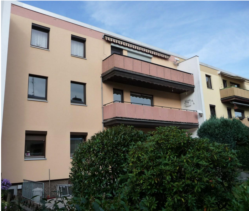
Rückansicht, Balkon 1. OG
