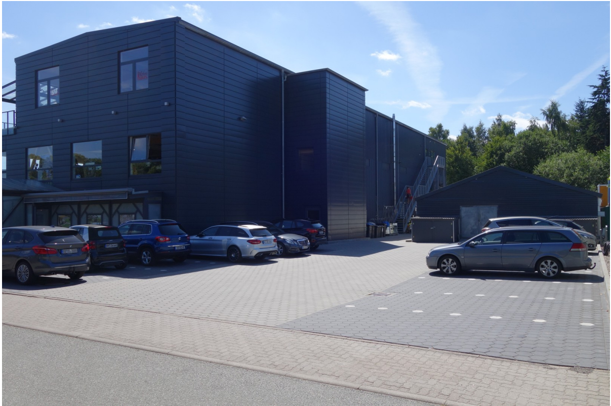
Rückseite und Parkplatz
