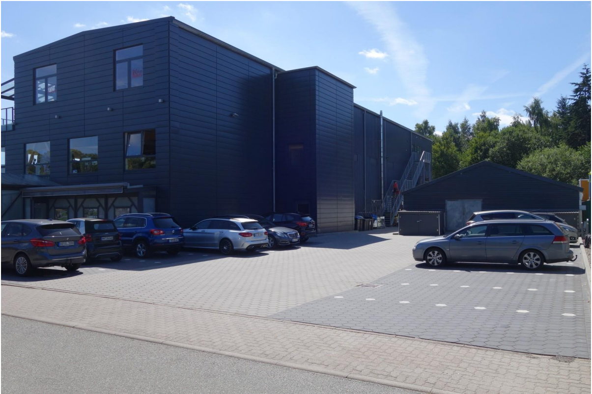
Rückseite und Parkplatz
