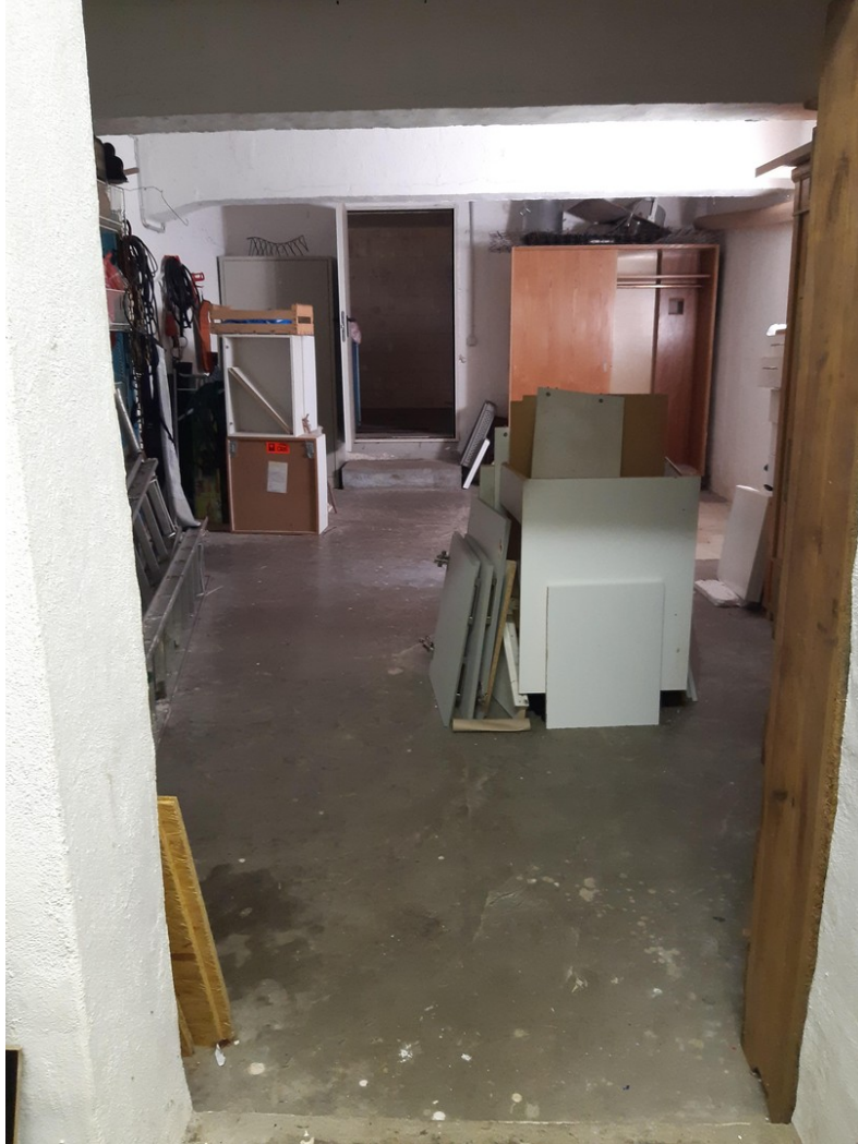
Keller zur Garage
