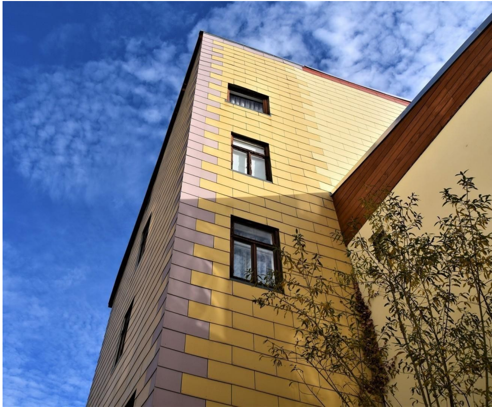
Ansicht Anbau Hohle Gasse
