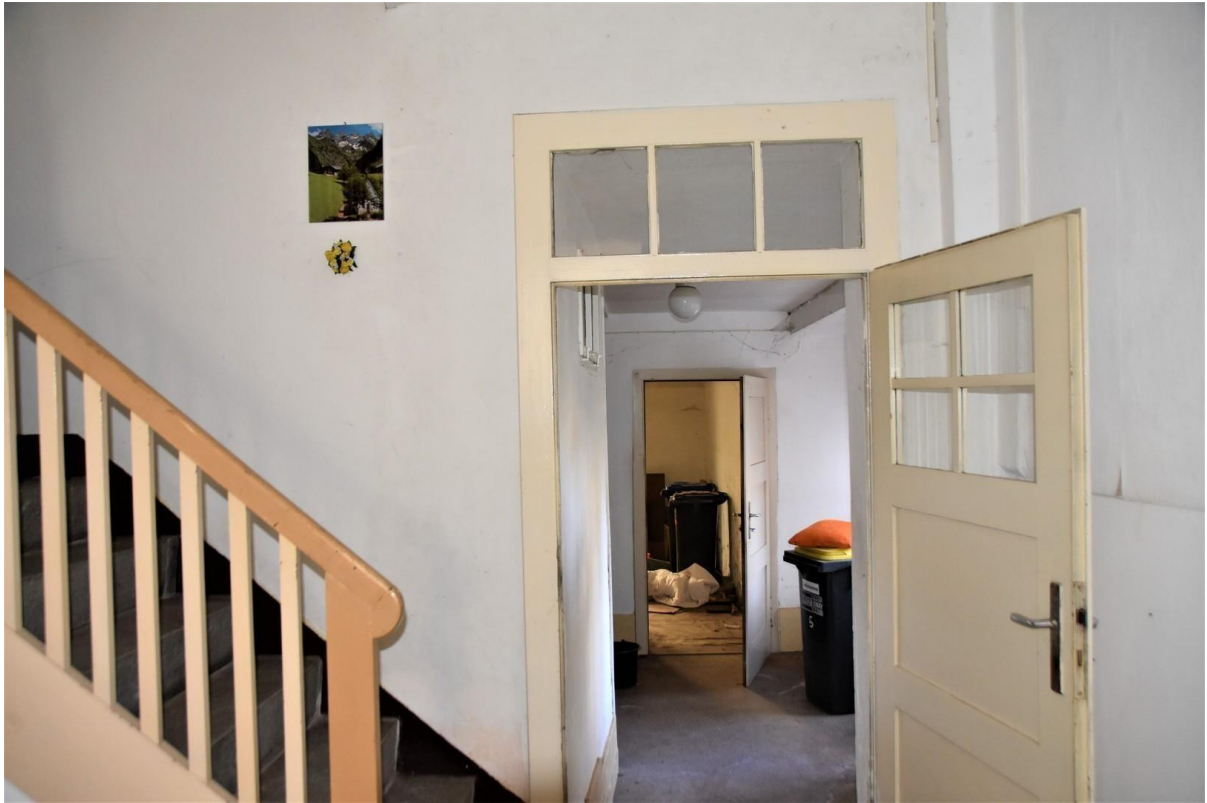
Tür EG zum Anbau
