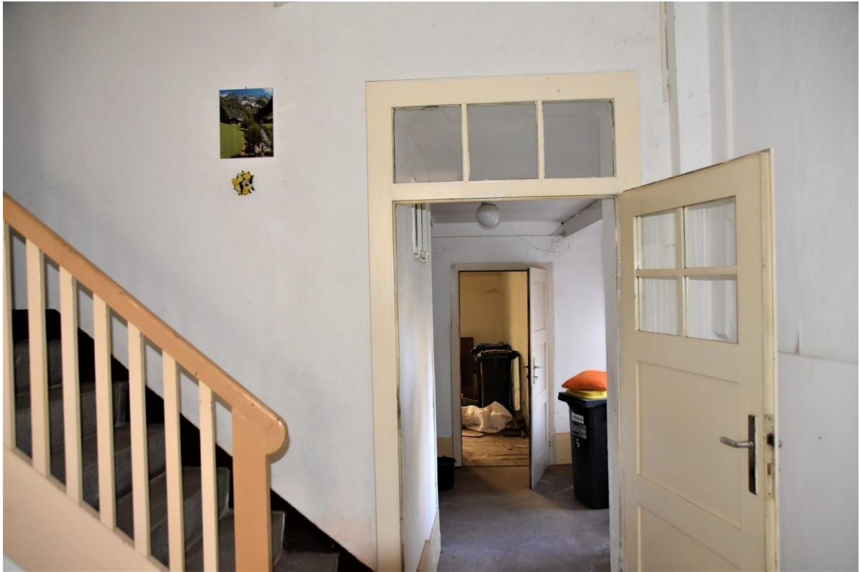
Tür EG zum Anbau
