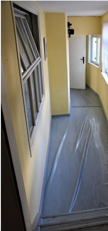
Flur 2. OG Anbau
