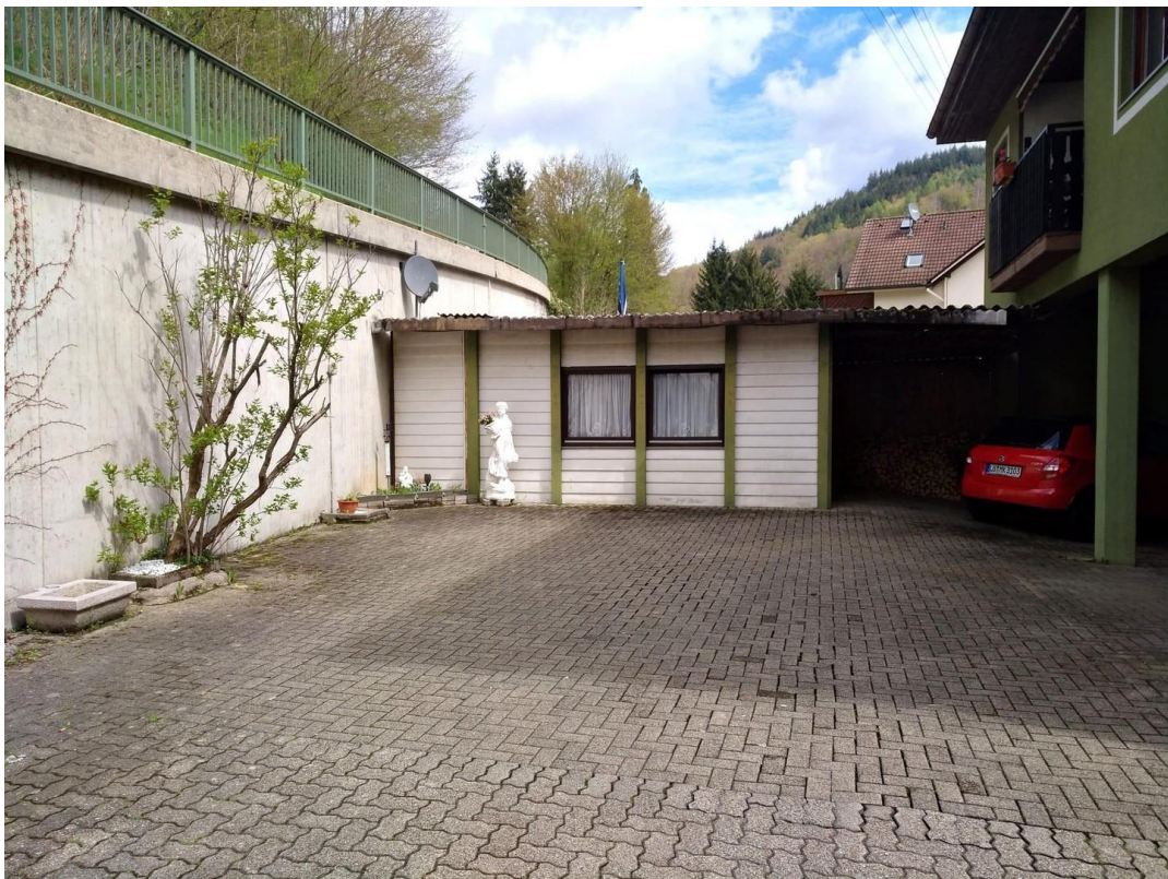
Ansicht Hof/ Garage
