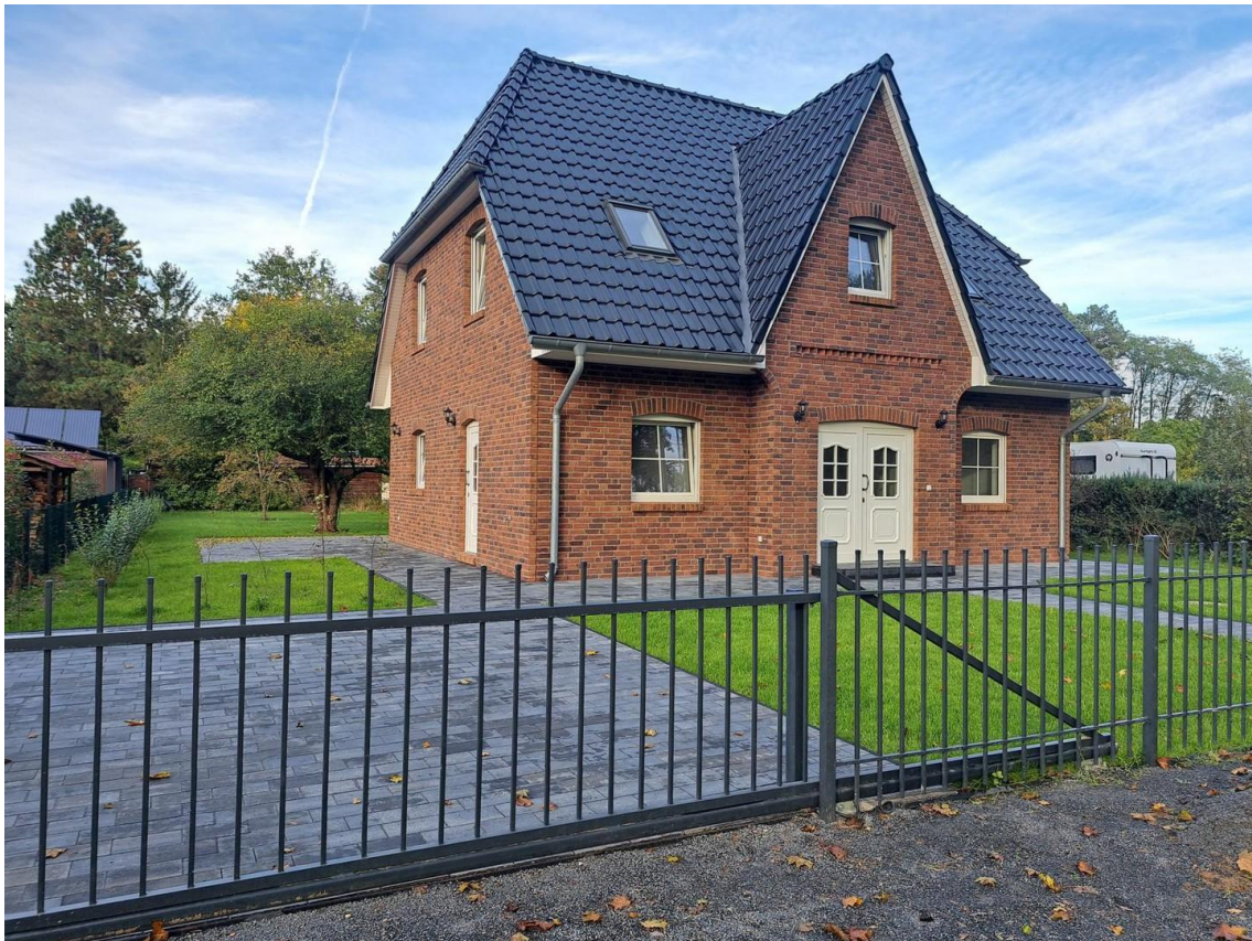
Haus mit Stellplatz
