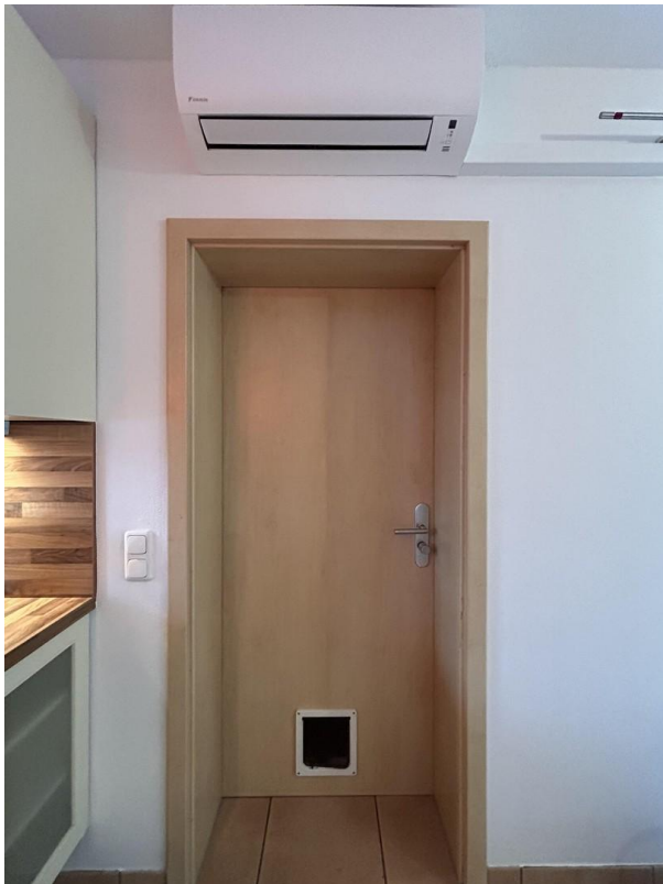
Zugang zur Garage
