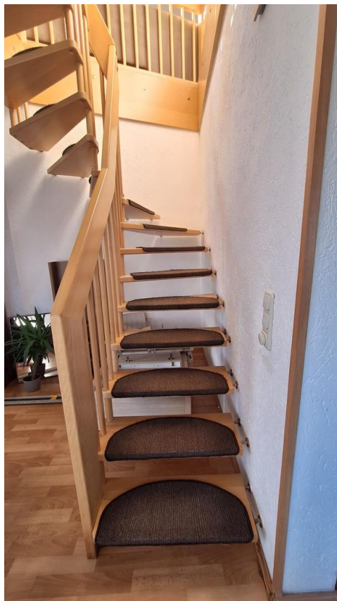
Treppe zum Dachgeschoss (4.OG)
