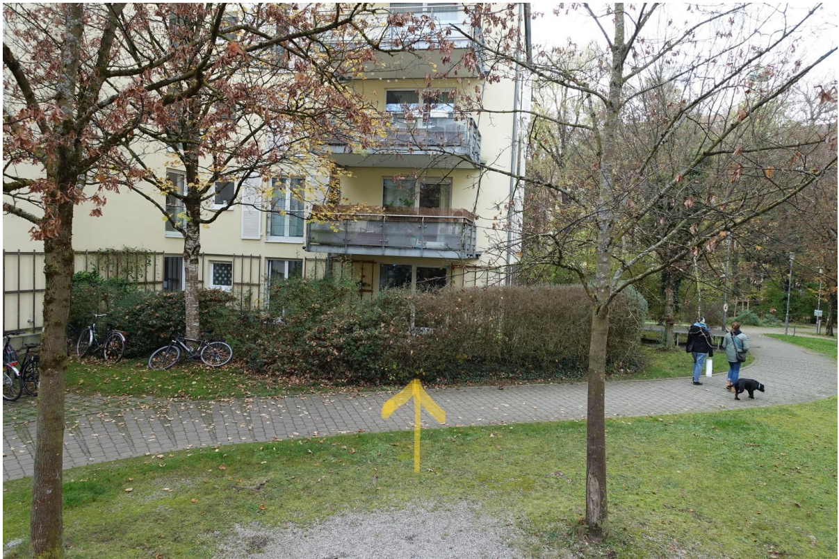
Terrasse u. Garten (Pfeil)
