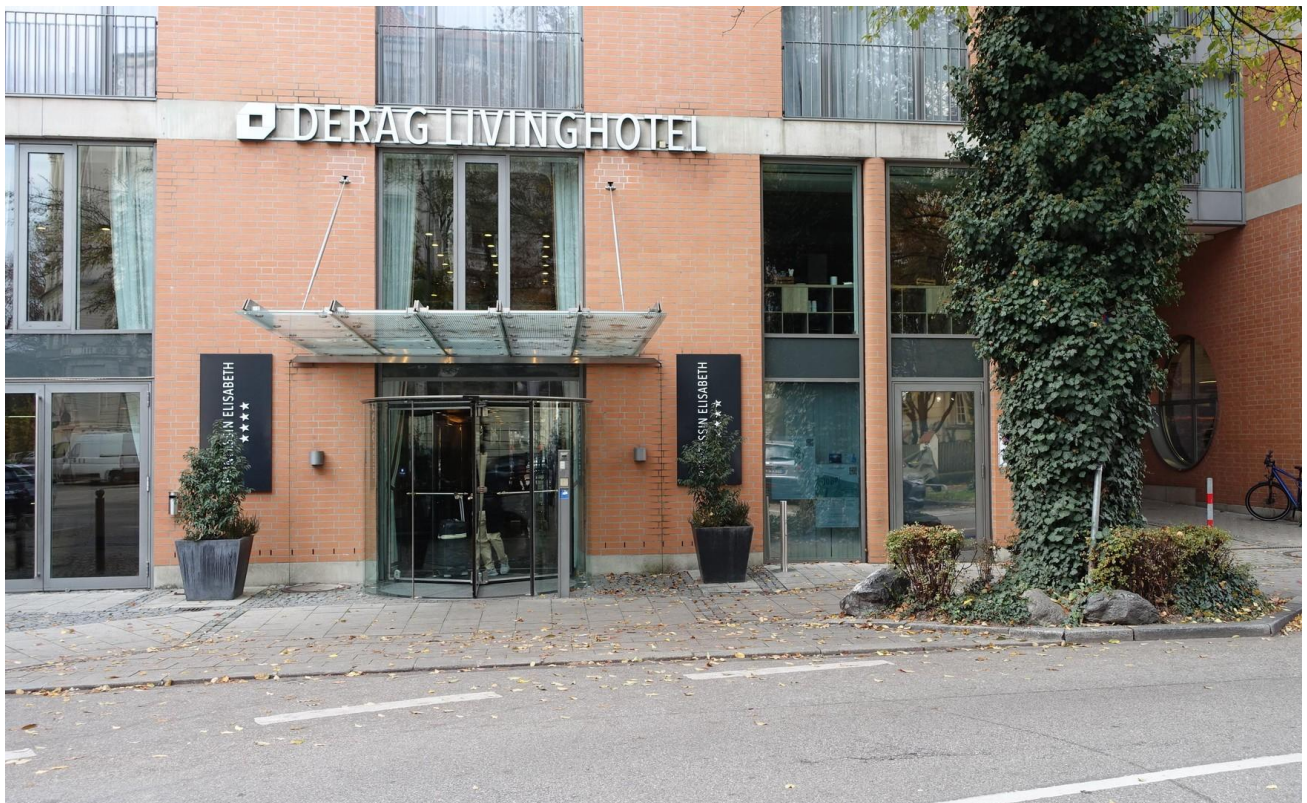
Rechts Durchgang z. Wohnanlage
