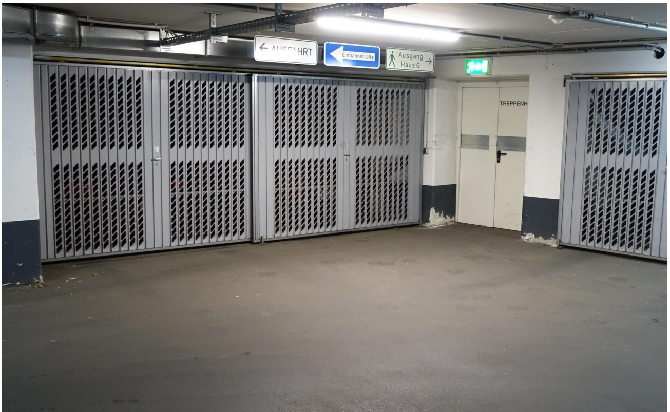
Tiefgarage und Zugang zum Haus
