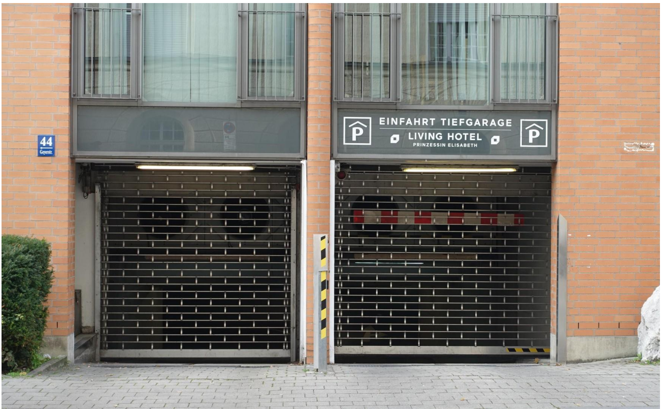
Ein- u. Ausfahrt Tiefgarage
