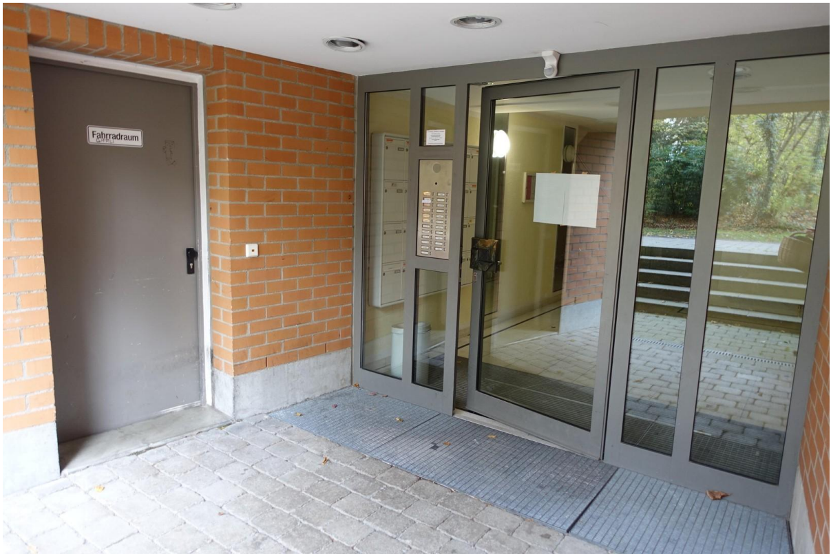
Hauseingang, links Fahrradraum
