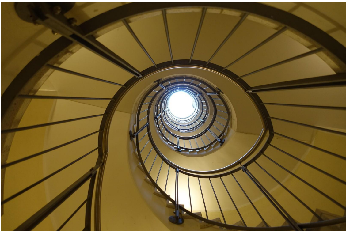
Treppenhaus (Blick nach oben)
