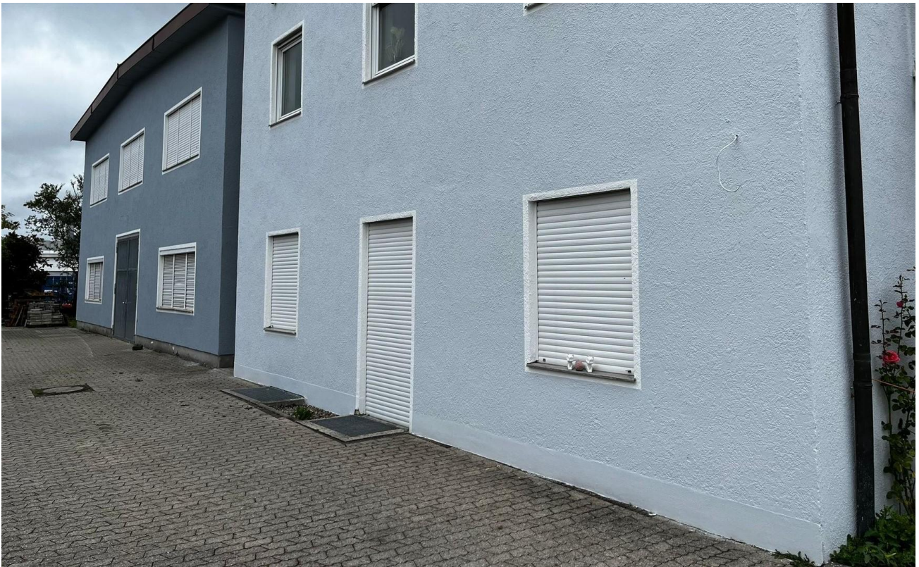
Büro + Lagerbereich eine Ebene
