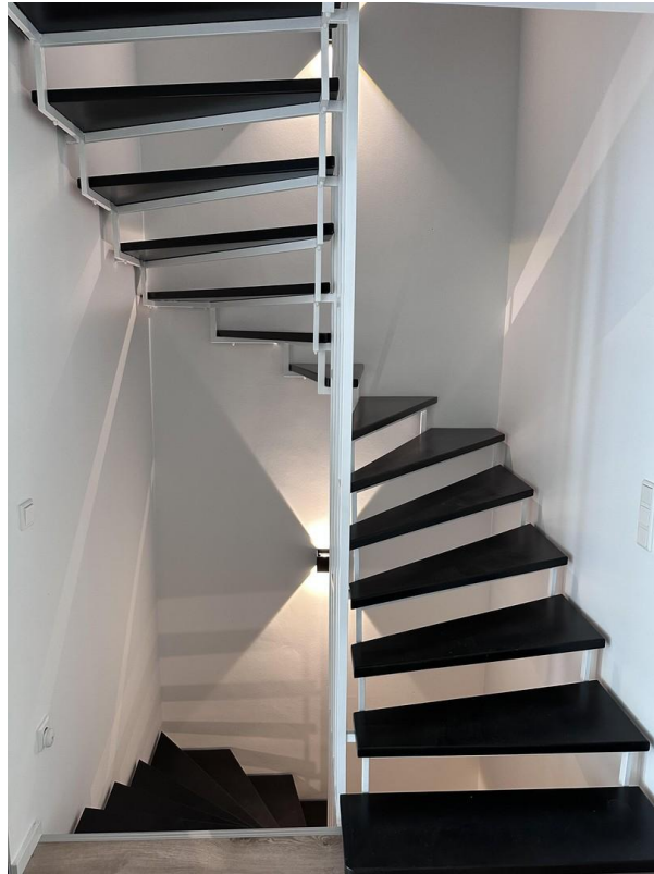
Treppe ins OG
