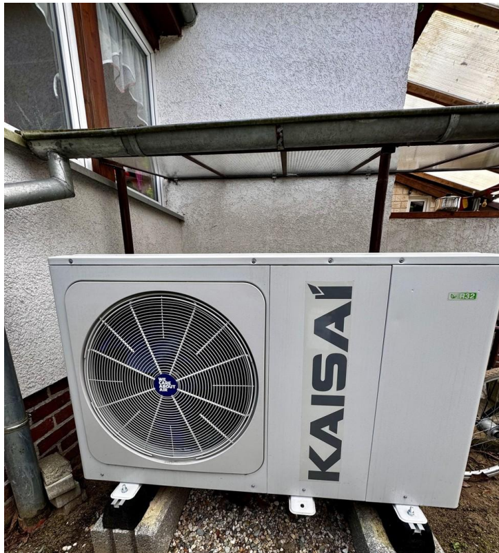
Wärmepumpe außen
