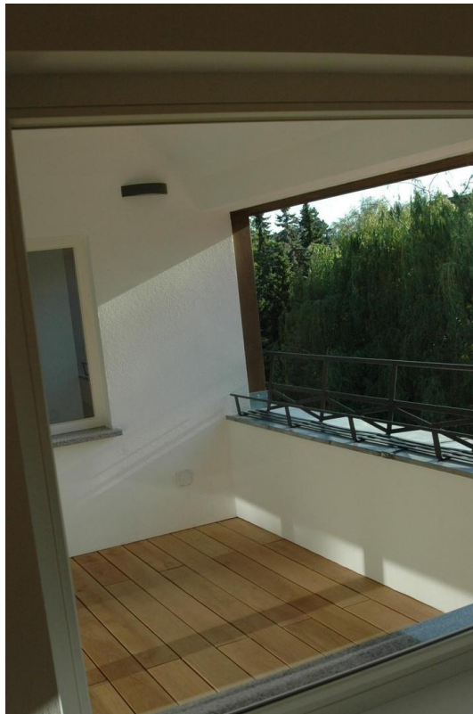
Loggia/Blick in den Garten
