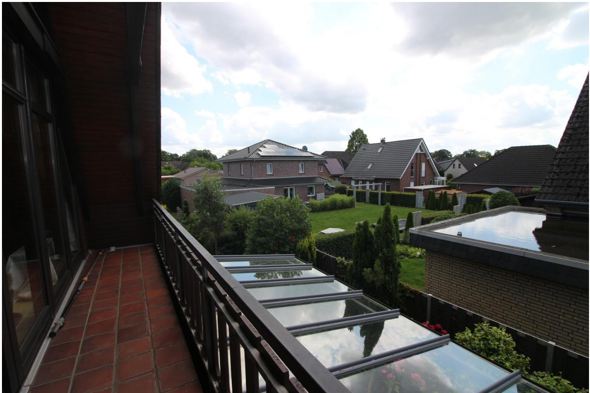
Balkon im OG
