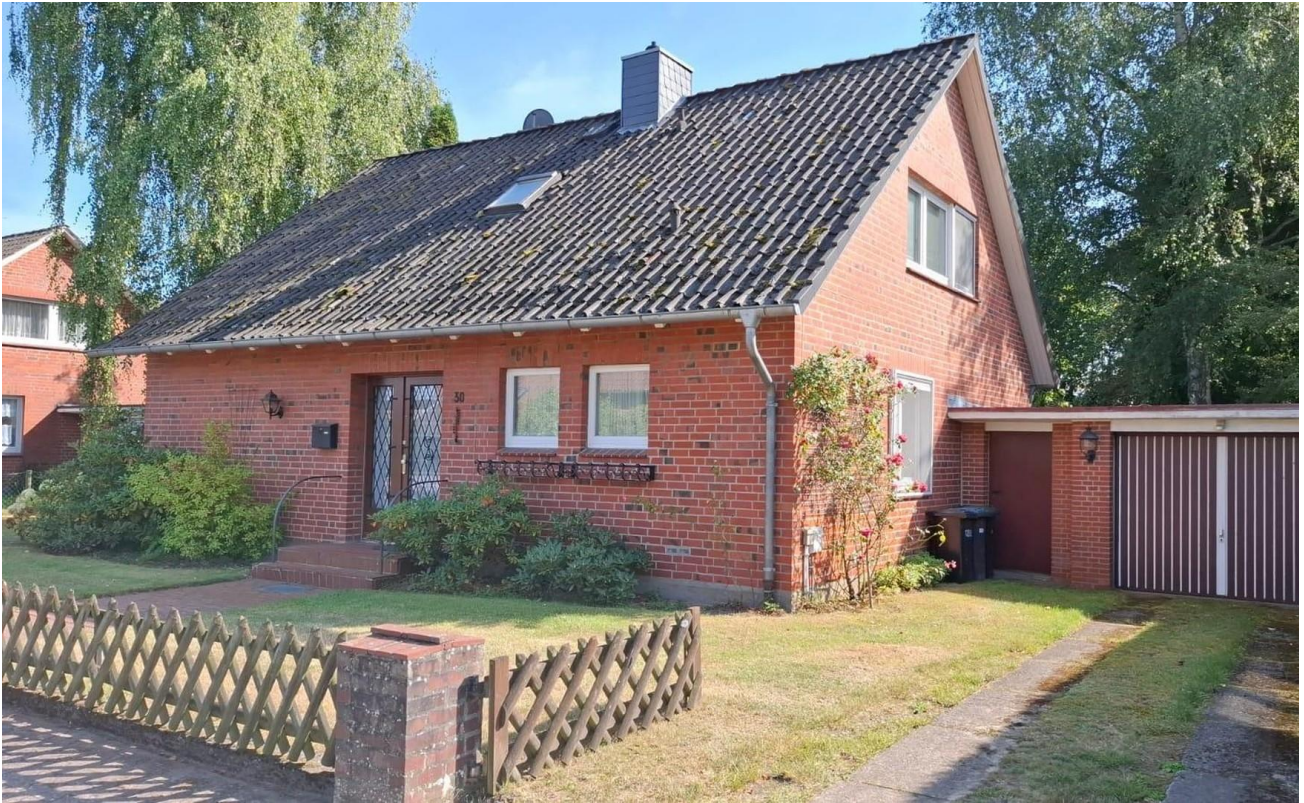
Seitenansicht mit Garage
