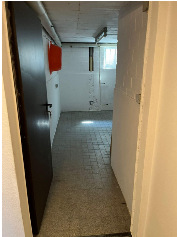
Keller, Zugang zur Waschküche
