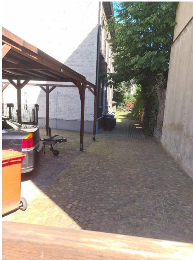
Einfahrt neu gepflastert
