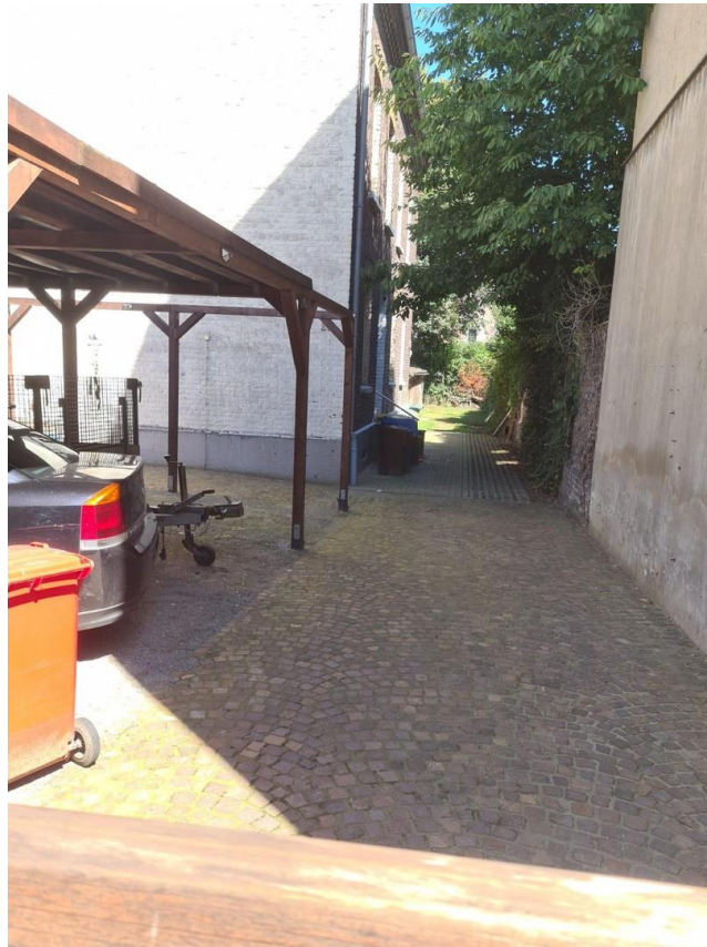
Einfahrt neu gepflastert
