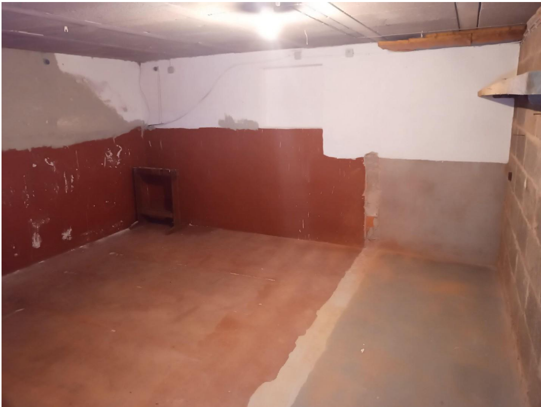
Vorrat früher Öltanks Keller
