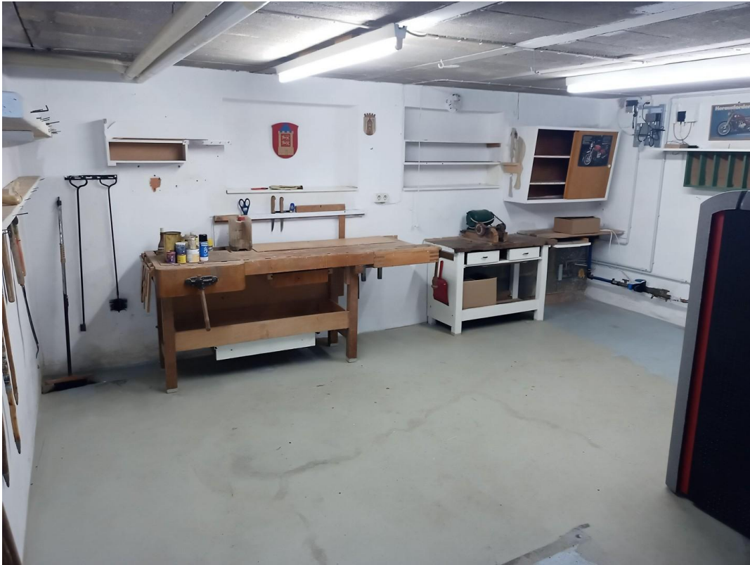
Werkraum Heizung Keller
