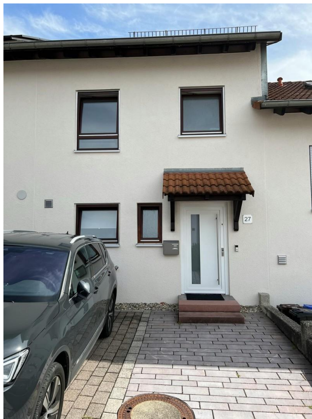
Ansicht West / Straßenseite
