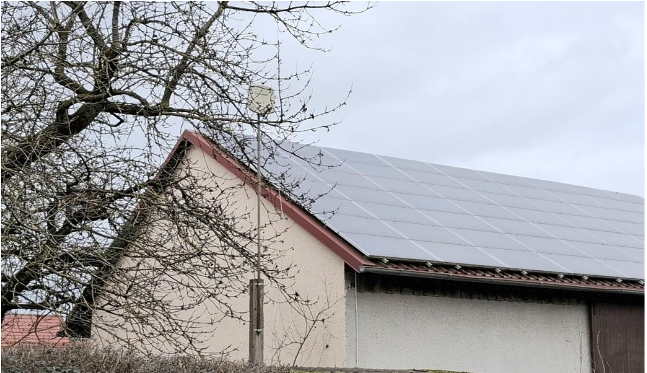
PV-Anlage 26 kW
