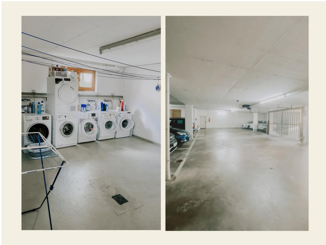
Waschküche und Tiefgarage
