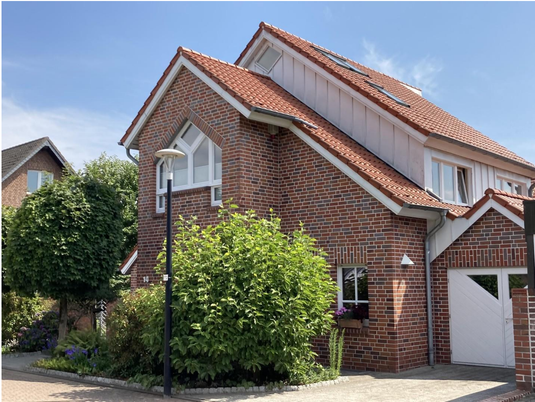
Frontansicht mit Garage
