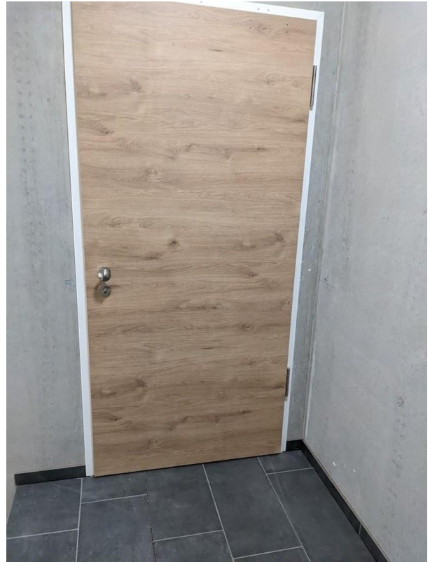
Büroeingänge vom Treppenhaus
