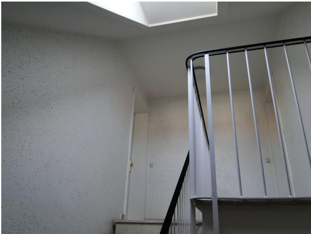
DG 3e Etage
