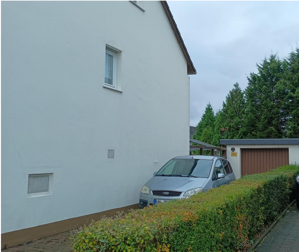
Einfahrt und Garage
