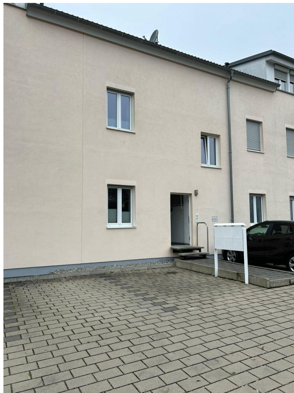
Stellplatz u. Hauseingang
