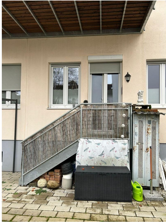
Treppe zur Terrasse
