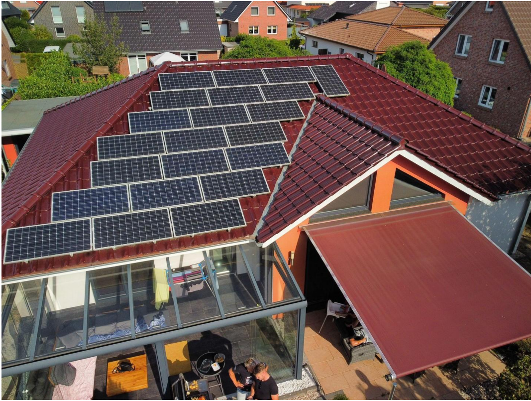
Blick auf das Dach
