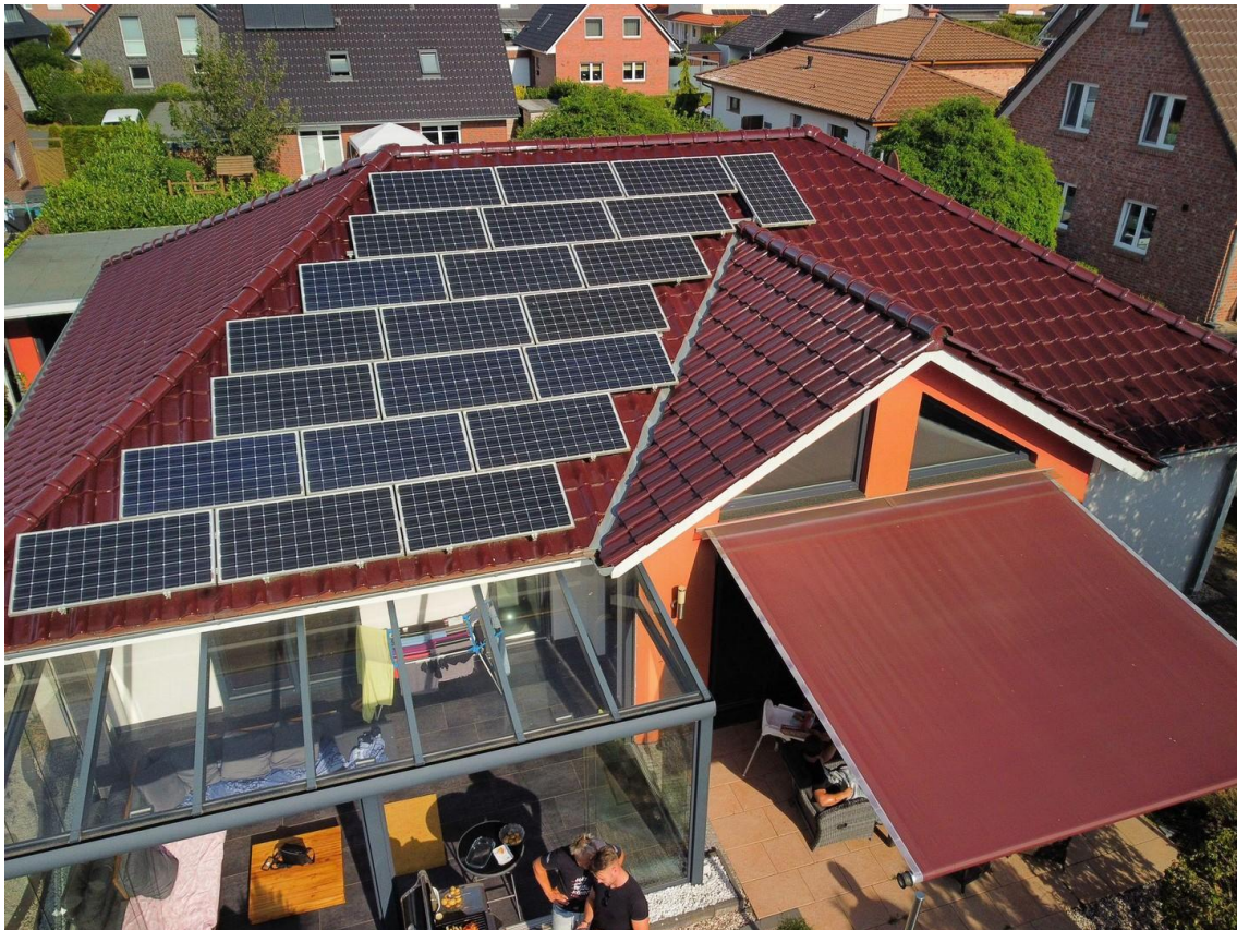
Blick auf das Dach
