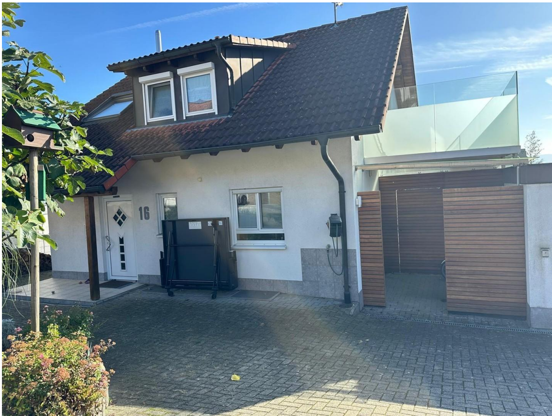
Haus Nordseite, Zufahrt
