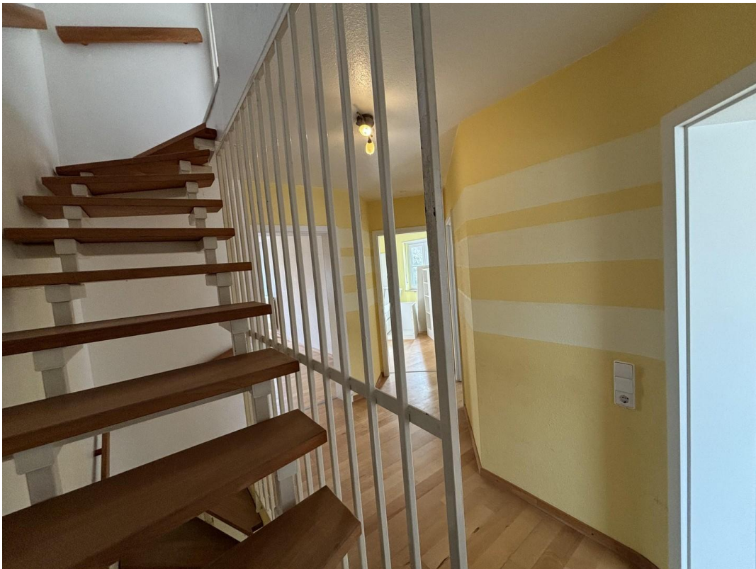
Treppenhaus zu 2.OG
