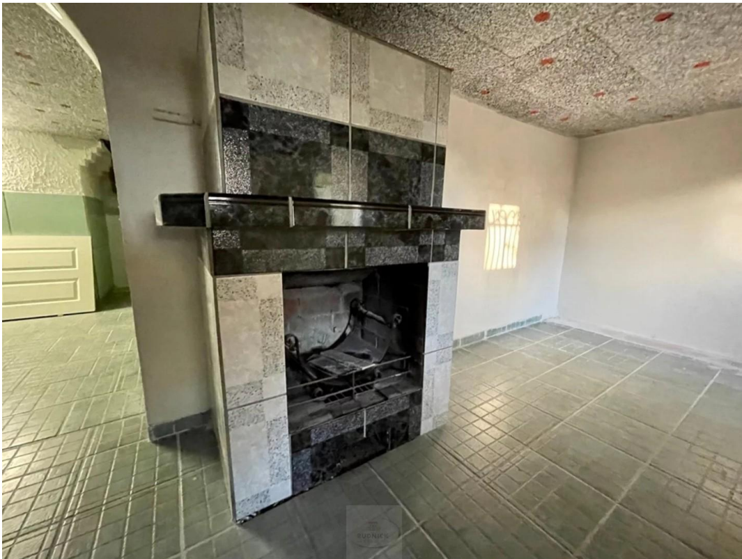
Einer von drei Kellerräumen
