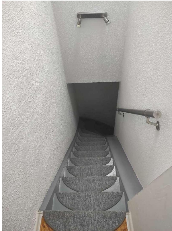
Treppe zum Dachboden
