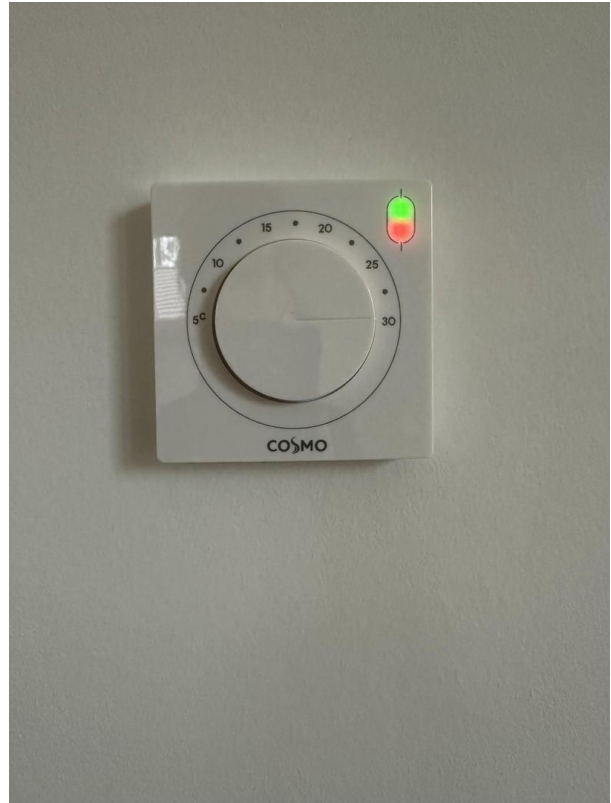
Fußbodenheizungsregler
